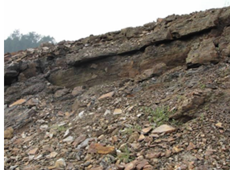
图3 滑坡右侧松弛岩体
