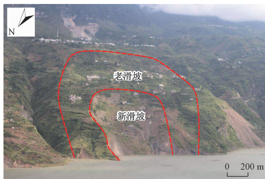
图 1 上坝滑坡全貌图
