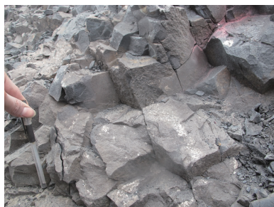
图2 应力调整导致微裂隙张开
