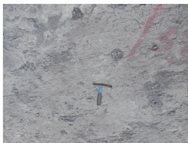
图3 保护层岩体葱皮现象
