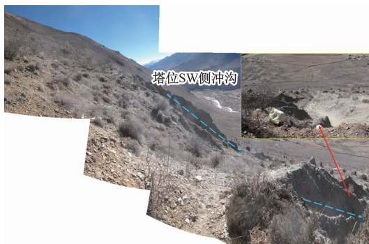
图 6 10L337 塔基全景
