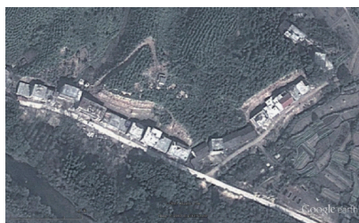
图5 沙溪镇某不稳定斜坡顶视图
