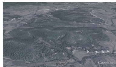
图7 沙溪镇地面塌陷3D图
