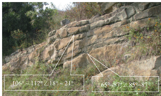
图 3 坡脚基岩露头
