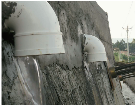
图 17 集水井出水口(左:出水口 1;右:出水口 2)
