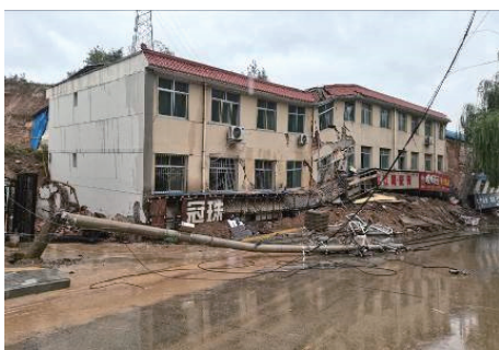
图 9 2#滑块前部拱起及破坏楼房
