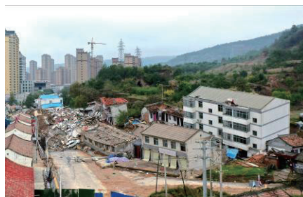
图 4 滑坡前缘破坏情况
