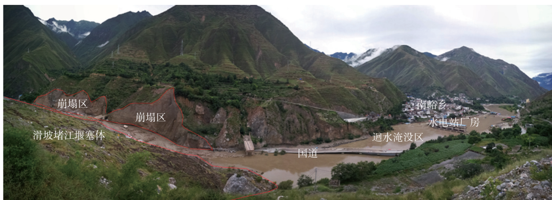
图 13 江顶崖滑坡堵江灾害效应图
